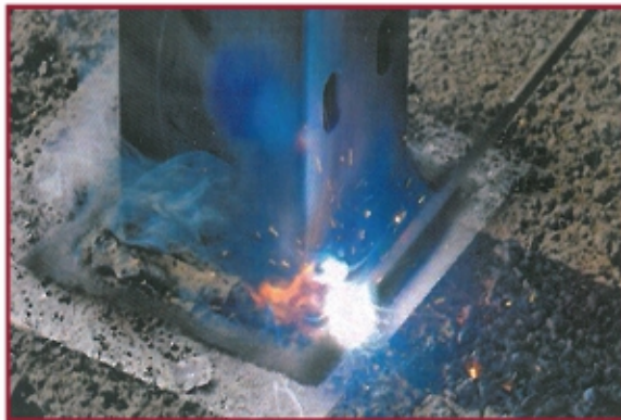
نصب سیستم نرده بر روی پلیت های انتظار - در محل هایی که بستر مقاوم وجود ندارد
