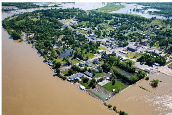
شکل ۳۸- اجرای سیل بند جهت حفاظت از مناطق مسکونی
