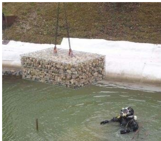
شکل ۵۰- حمل با جرثقیل گابیون های از پیش پر شده
