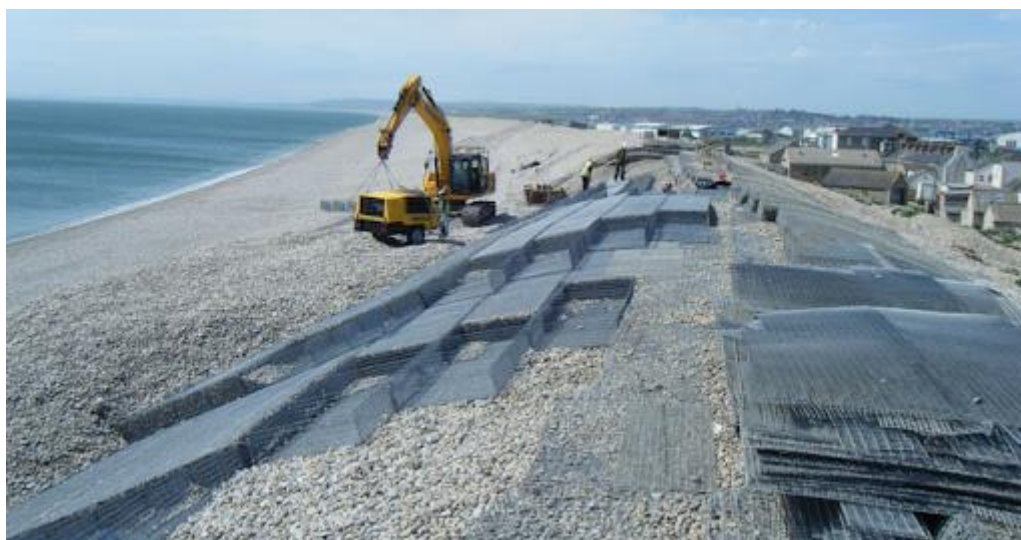
شکل ۲۷- اجرای تشک های گابیونی در سواحل
