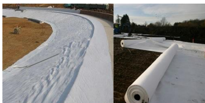
شکل ۴- پوشش کف توسط ژئوتکستایل قبل از اجرای گابیون‌ها
