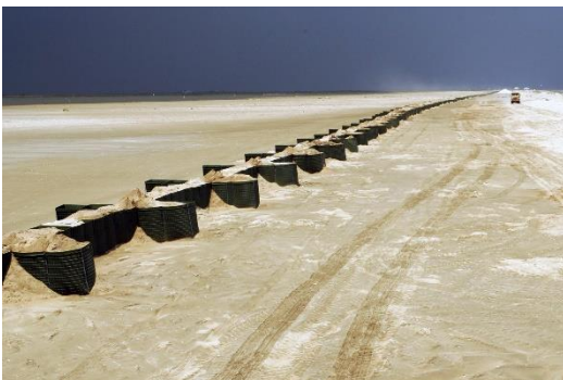
شکل ۳۵- اجرای دیوار بادشکن گابیونی
