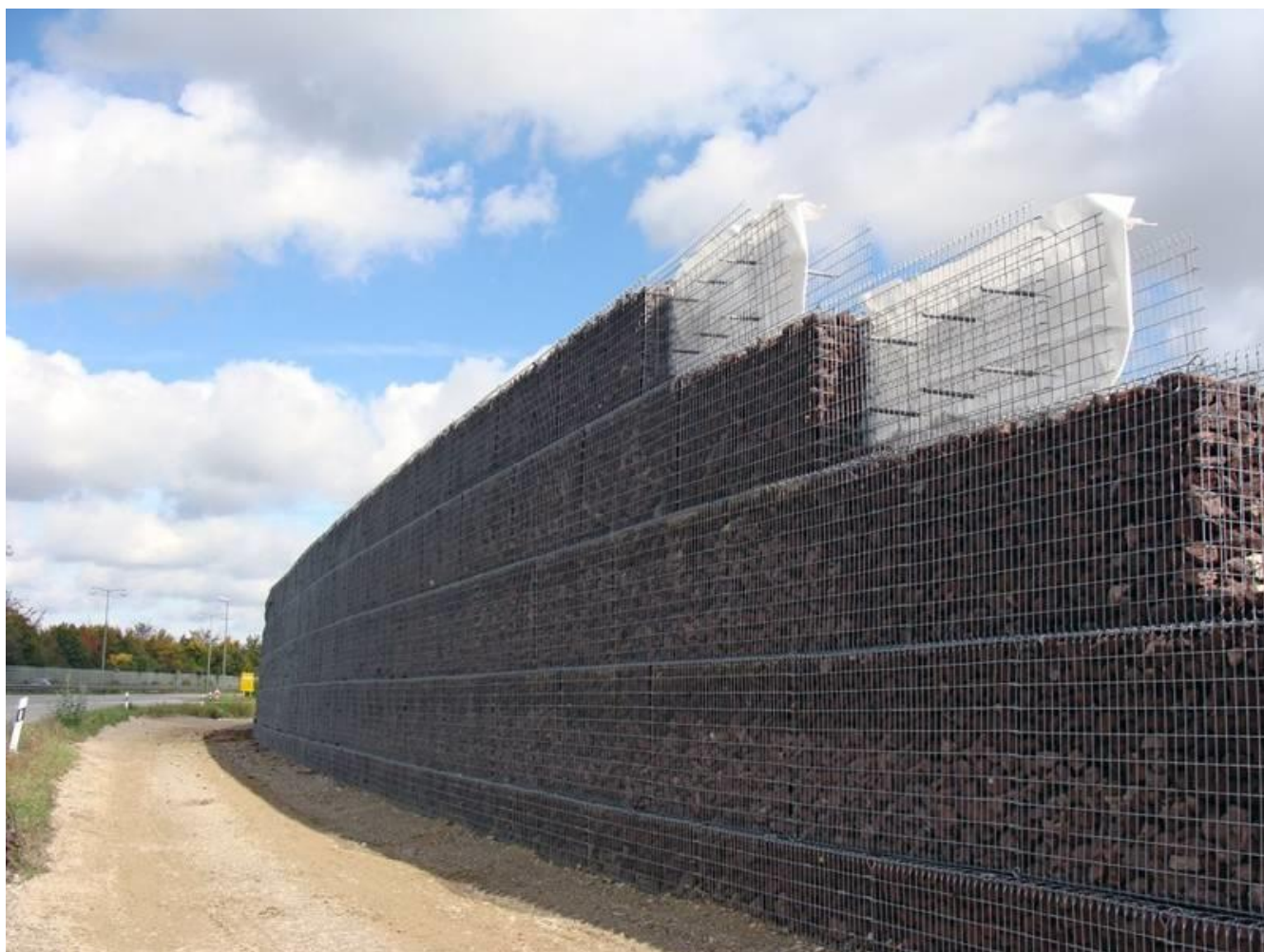
شکل ۲۱- دیوار حائل کابیونی با پوشش ژئوتکستایل جهت تثبیت خاک
