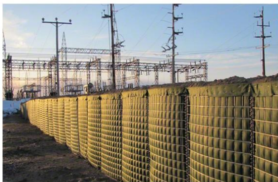
شکل ۴۲- اجرای سیل بند جهت حفاظت از تاسیسات
