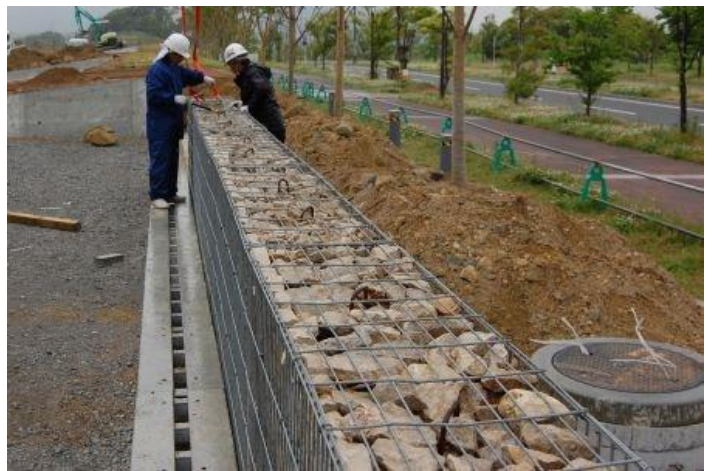
شکل ۴۳- اجرای سیل بند دائمی جهت حفاظت از حریم جاده
