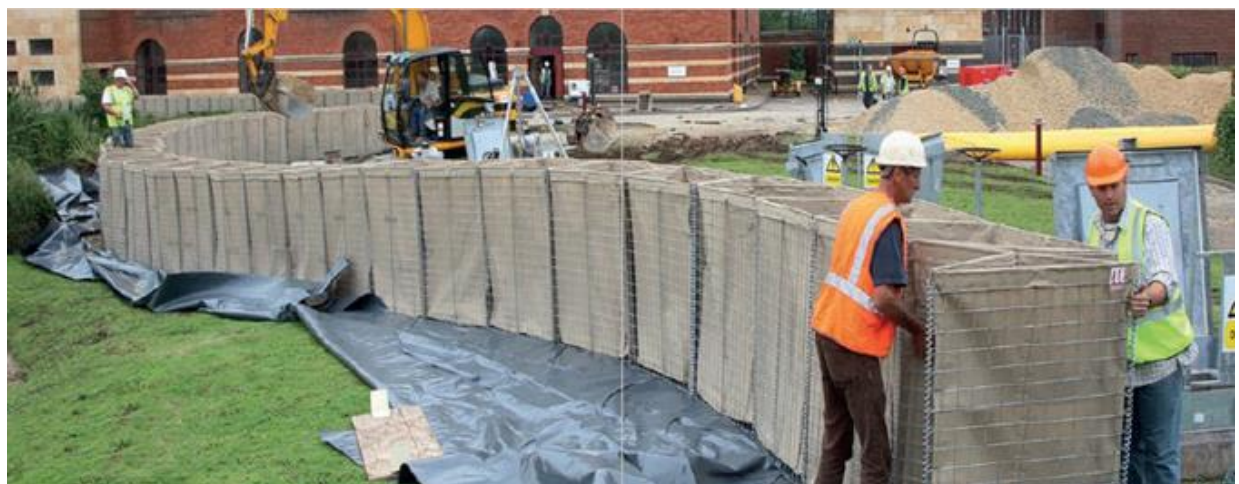
شکل ۳۷- سرعت بالای اجرای سیل بند در زمان بحران سیلاب
