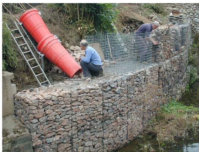
شکل ۲- پر کردن گابیون‌ها به صورت دستی
