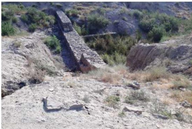
شکل ۱۱- فرسایش ناشی از آنکراژ غیر اصولی در تکیه گاه با خاک واگرا
