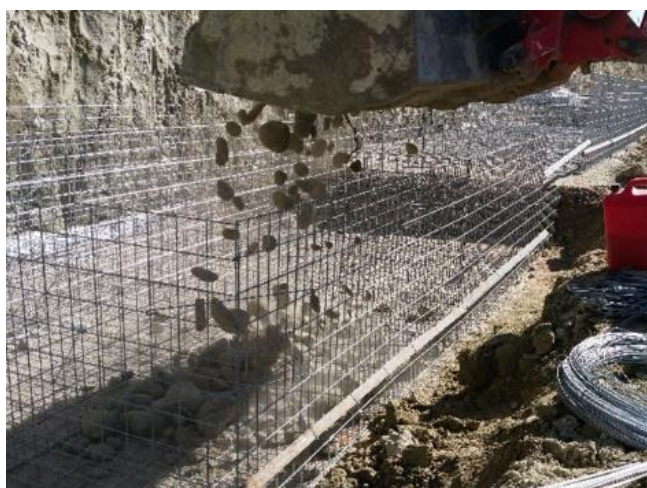
شکل ۳- پر کردن گابیون‌ها به صورت مکانیکی
