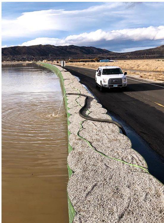
شکل ۴۰- اجرای سیل بند در اطراف جاده
