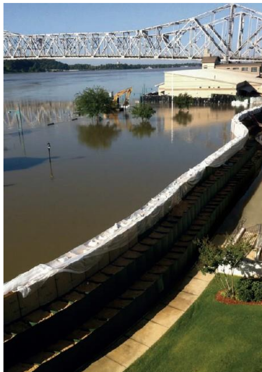
شکل ۳۹- اجرای سیل بند در حریم رودخانه
