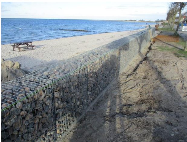
شکل ۴۴- اجرای سیل بند دائم جهت حفاظت از سواحل
