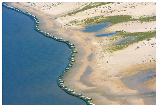
شکل ۴۱- اجرای موج شکن کایونی با هسته خاکی در سواحل
