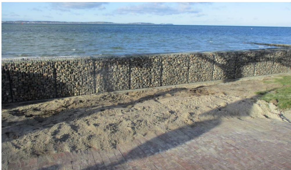
شکل ۴۵- نمای دیگر از سیل بند گابیونی دائمی جهت حفاظت از سواحل
