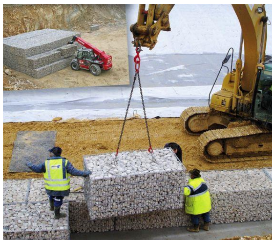
شکل ۵۰- حمل با جرثقیل گابیون های از پیش پر شده
