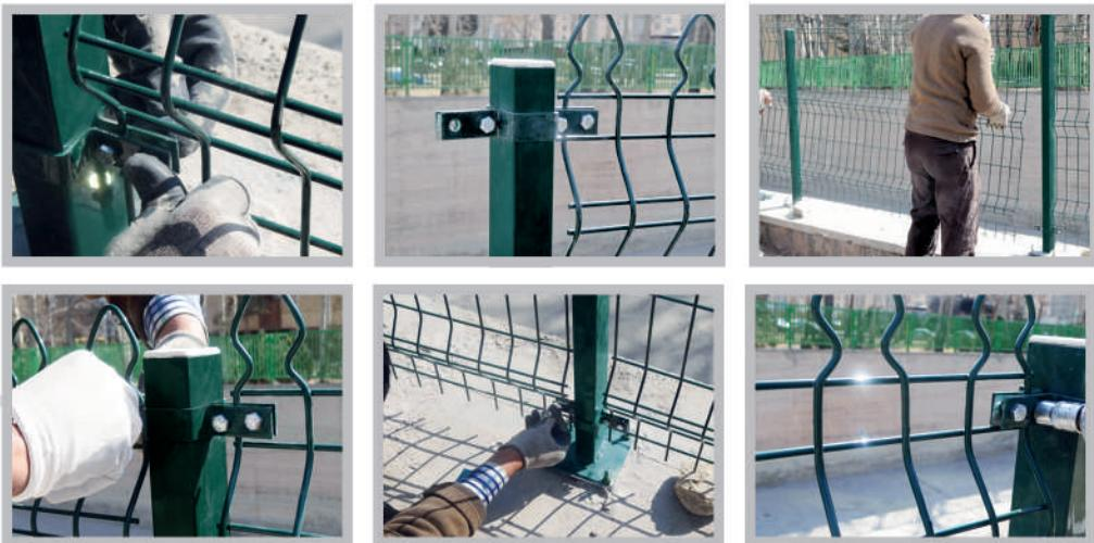
**نکته ۱:** محل قرارگیری بست ها می بایست کاملاً مطابق با نقشه مربوطه باشد. جانمایی و تعداد بست ها در مقاومت حداکثری نرده ها موثر است.
